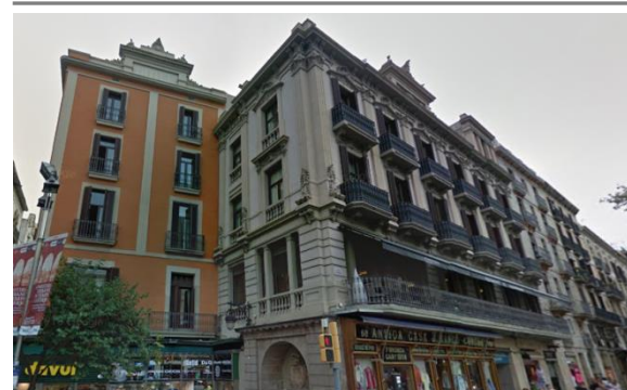
Fotografía de la inspección de EY
